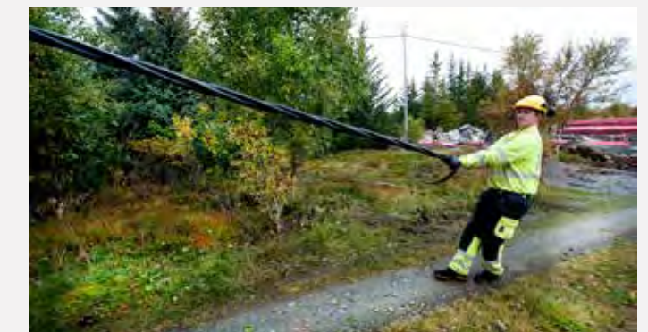
Det er tungt arbeid å dra kabelen ut av kabeltrommelen.
