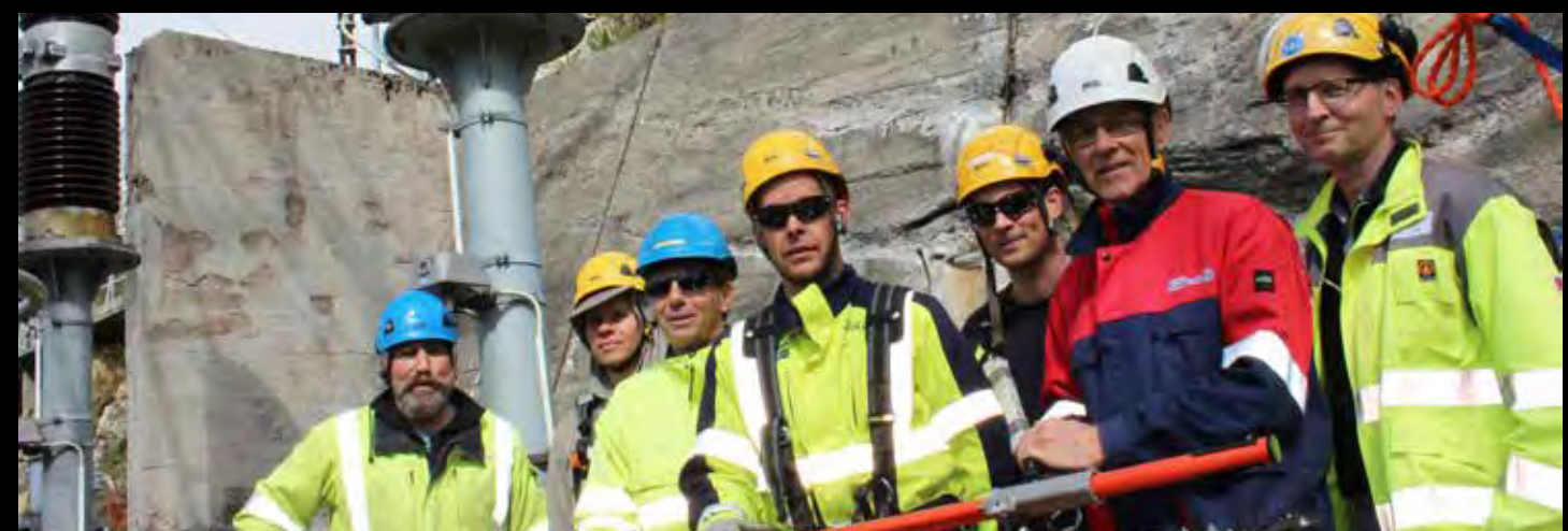
Flere av Helgeland Krafts montører er i stand til å utføre arbeid på anlegg som fører 132.000 volt, uten at strømmen ut til kundene må kuttes.
