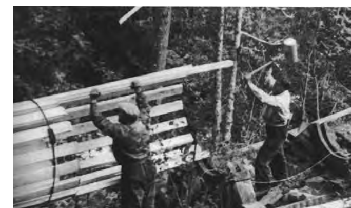
Bygging av rørgate i Andåsfossen. Vannrøret er i dag fortsatt i tre.
