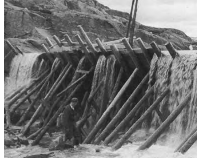
Nye Langfjord kraftverk settes i drift.
