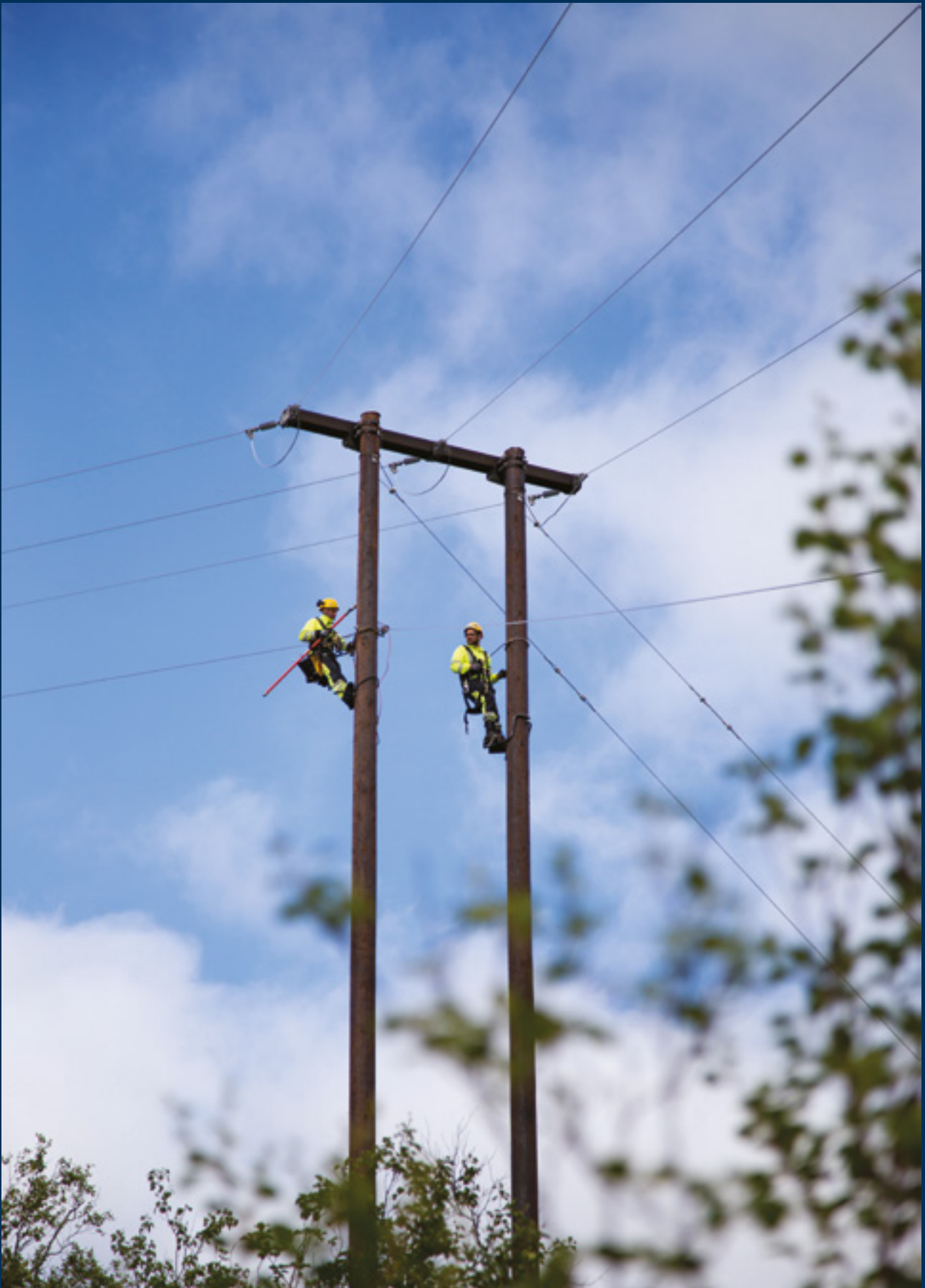
Montører fra Helgeland Kraft Nett utfører vedlikeholdsarbeid på strømmettet i Hundåla i Vefsn kommune for å bidra til at 100 % fornybar strøm kommer trygt fram til strømkundene.
