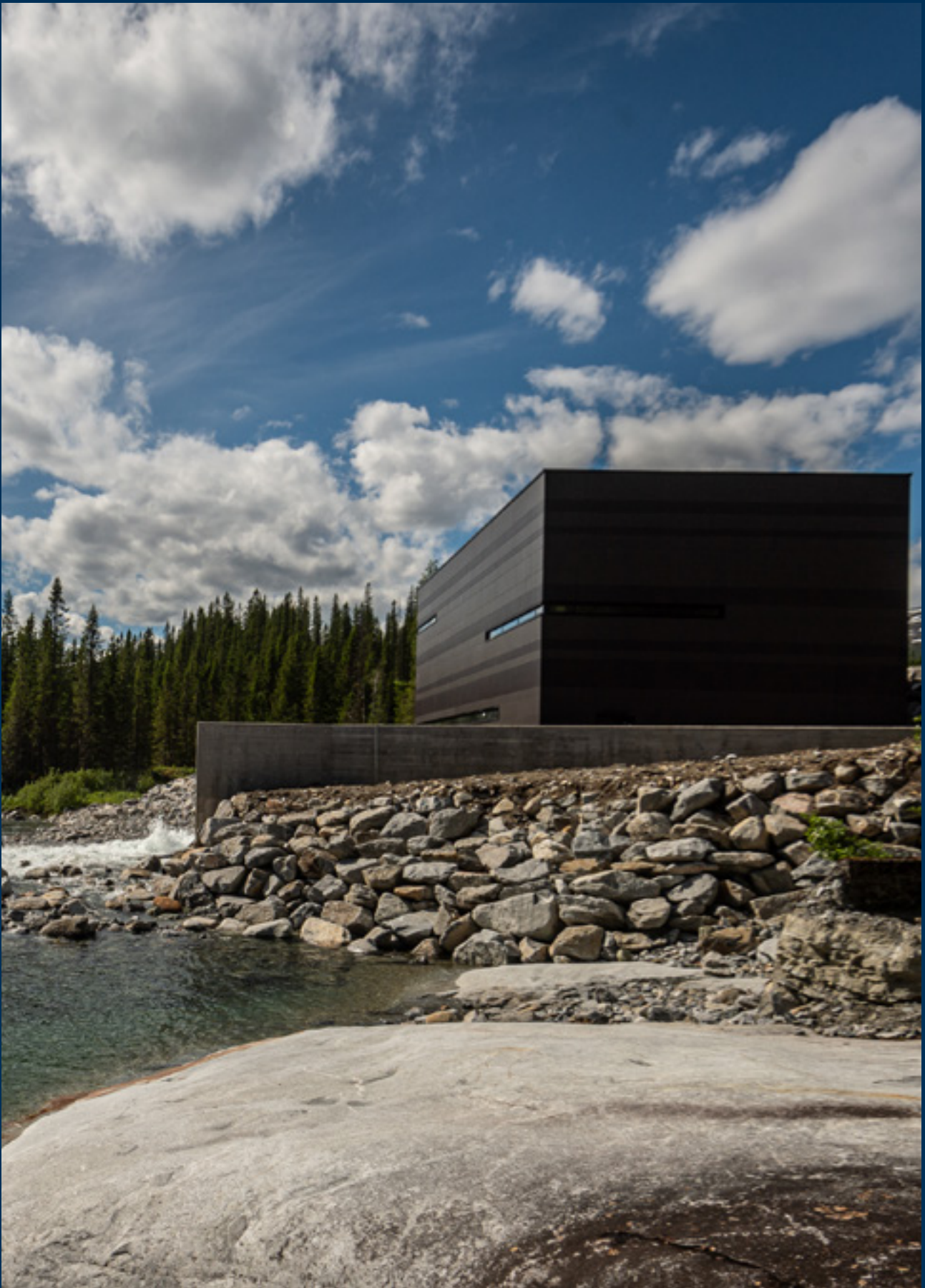
Storelva Kraftverk i Tosbotn er det tredje av de fem nye kraftverkene i Tosbotn som er bygget etter samme bærekraftige prinsipper som Øvre Forsland i Leirfjord kommune.
