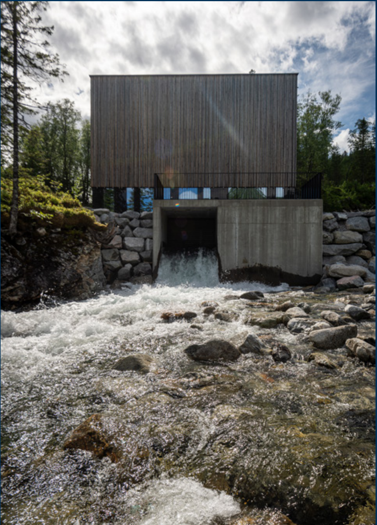
Leiråa Kraftverk i Tosbotn er bygget etter samme bærekraftige prinsipper som det prisvinnende kraftverket vårt Øvre Forsland i Leirfjord kommune.
