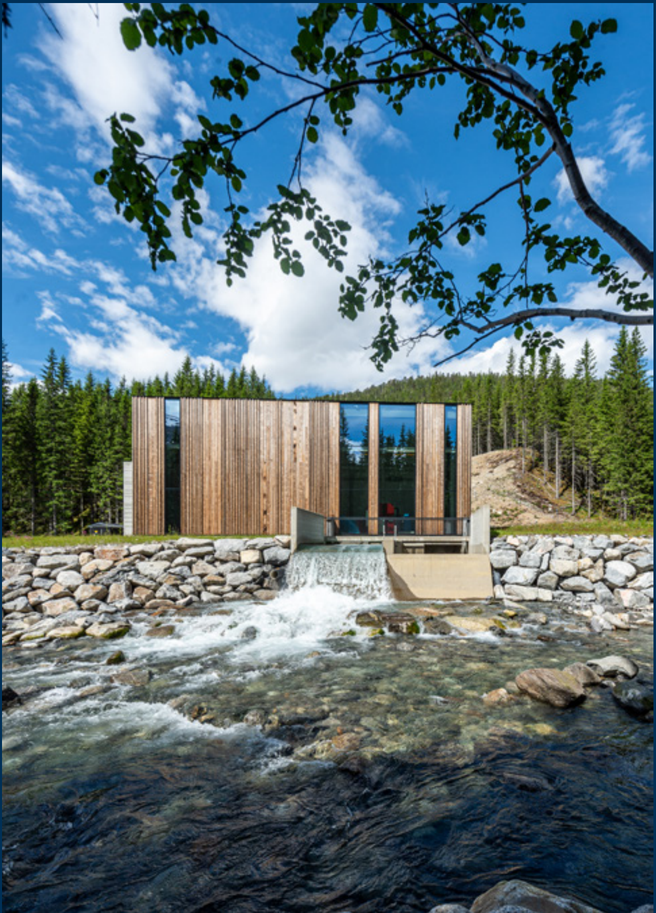
Tverrå Kraftverk i Tosbotn er også bygget etter samme bærekraftige prinsipper som det prisvinnende kraftverket vårt Øvre Forsland i Leirfjord kommune.
